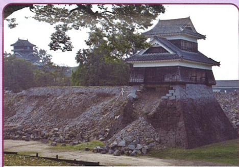
熊本地震被災状況視察/2016.10
